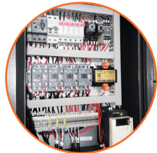
Panel eléctrico que integra protecciones, transformador y variador de frecuencia para el control y resguardo de los motores.
