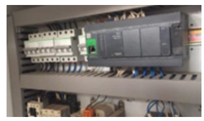
PLC marca Allen-Bradley, fabricado en USA Asegura una operación estable y confiable
